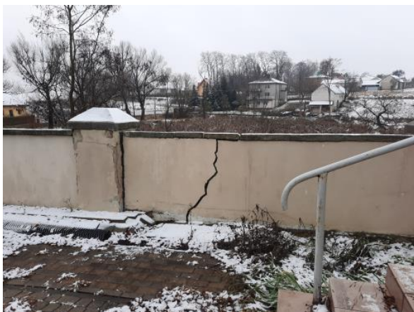
Uszkodzenie – pęknięcie muru przy budynku gosp.
