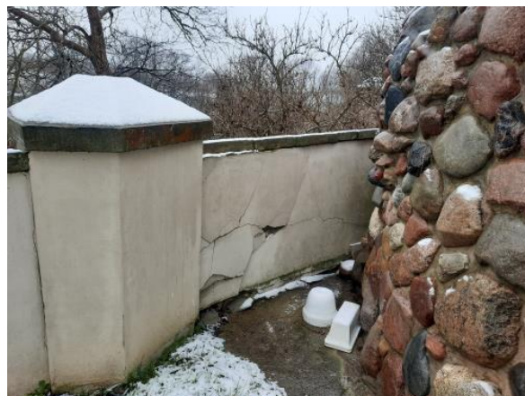
Uszkodzenie – pęknięcie muru przy grocie.
