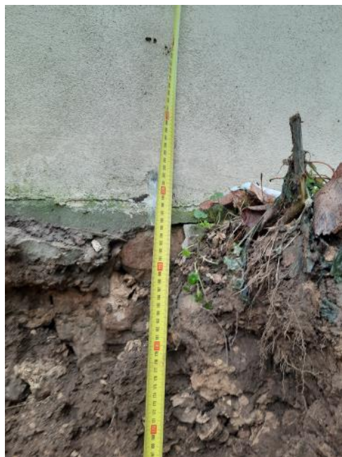
Odkrywka fundamentu muru OM-4
