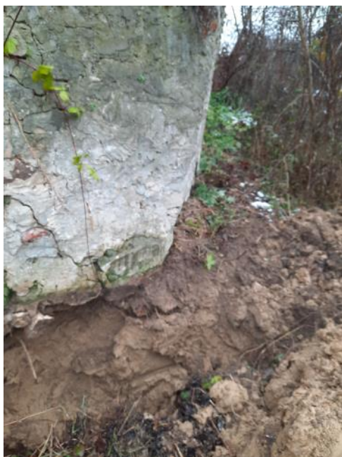
Odkrywka fundamentu muru OM-1
