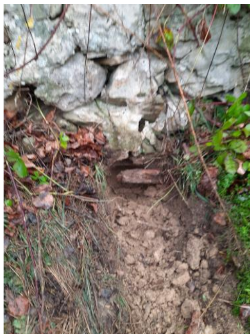
Odkrywka fundamentu muru OM-2
